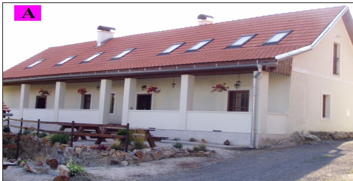
Obr. č. 1.: Objekt „A“
